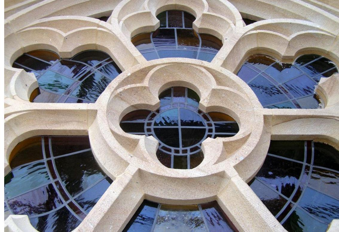
nen Fenster ausgeführt werden musste. Vor dem Ausbau der geschädigten Maßwerkteile wurden diese vor Ort mit Hilfe eines aufgezeichneten Strichsystems mit dem digitalen Aufmaßsystem Proliner der Firma Prodim dreidimensional erfasst. Unter Zuhilfenahme der so erfassten Messdaten sowie zusätzlich vorliegenden Papp-Schablonen der ausgebauten Fensterscheiben konnte die genaue Werkplanung bzw. Maßwerkkonstruktion im Büro der SDC erfolgen.
